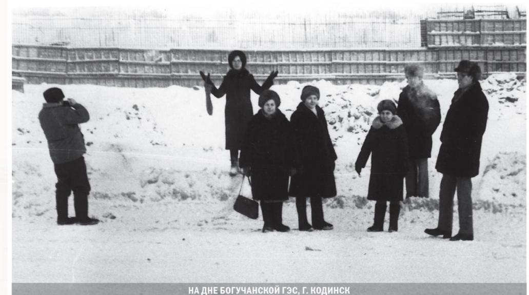
НА ДНЕ БОГУЧАНСКОЙ ГЭС, Г. КОДИНОК
