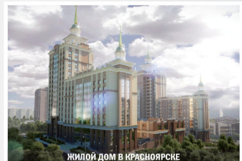
ЖИЛОЙ ДОМ В КРАСНОЯРСКЕ
